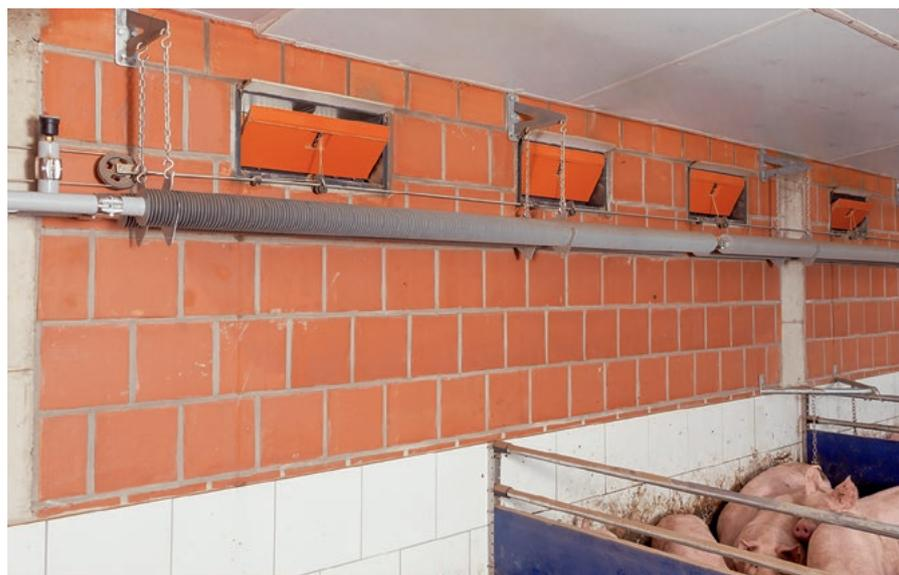
Chauffage des bâtiments avec un radiateur alu à ailettes – s'utilise idéalement avec les volets d'entrée d'air
