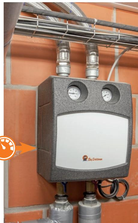
L'automate de climatisation 235pro synchronisé au réglage 3-voies assure un niveau de température constant dans deux compartiments
