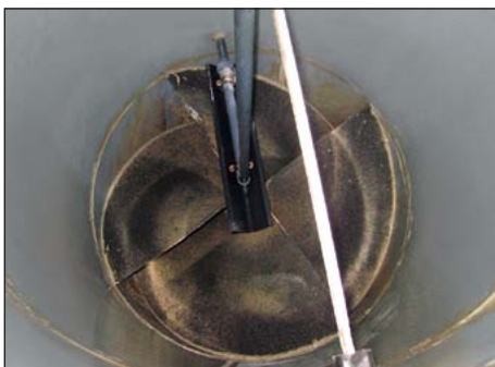
Vue sur le collecteur hélicoïdal avec sortie
